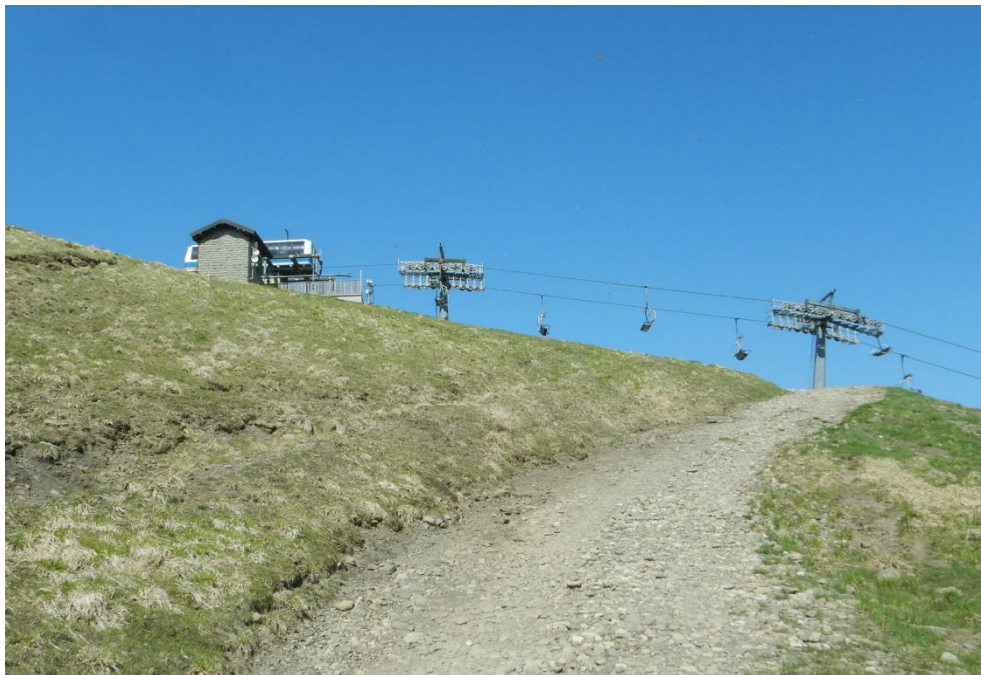
Figura 42 - Stazione di Monte impianto Direttissima
