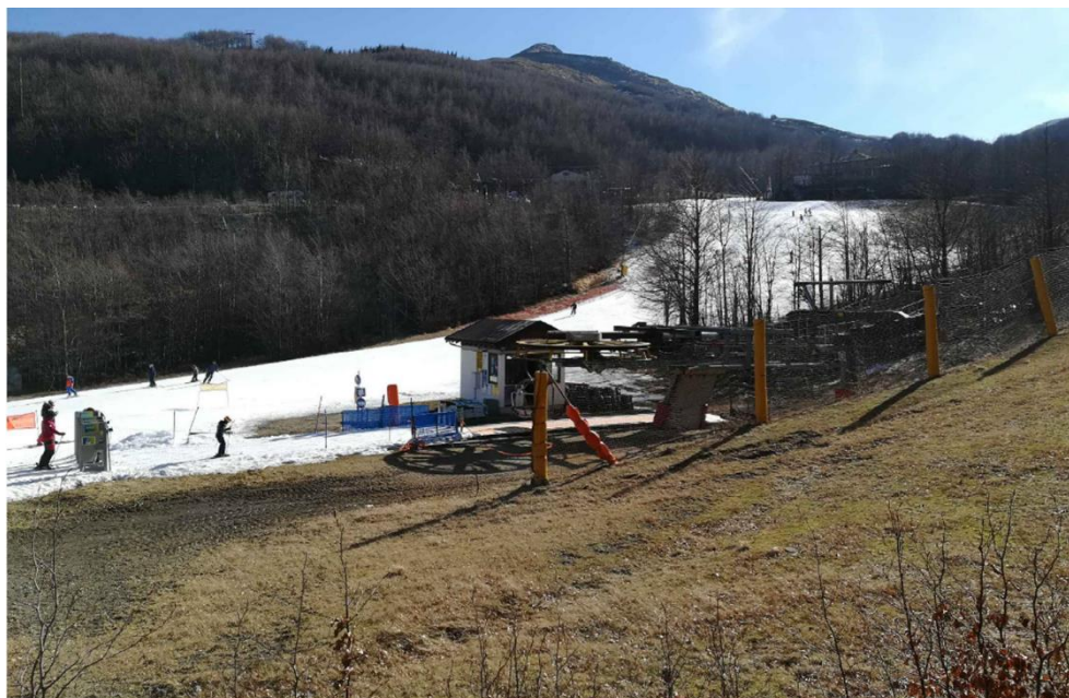
Figura 37 - Stazione di Valle impianto Direttissima
