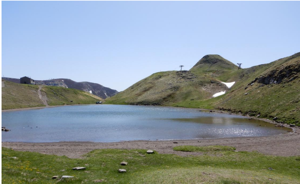
Figura 45 - Impianto Cupolino vista dal lago Scaffaiolo
