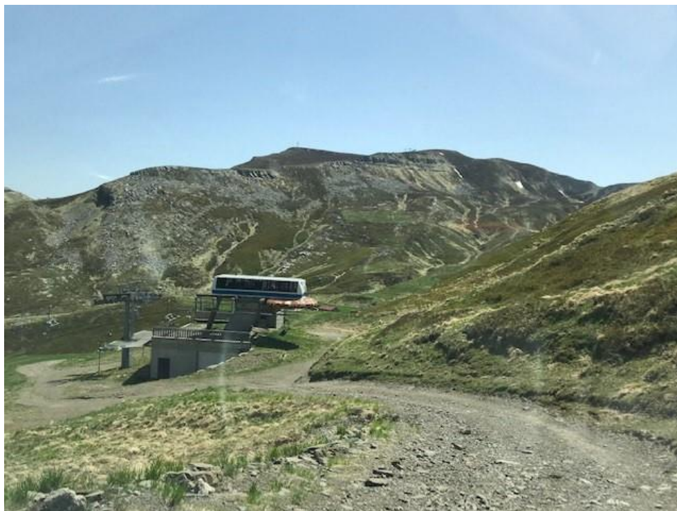
Figura 43 - Stazione di Monte impianto Direttissima
