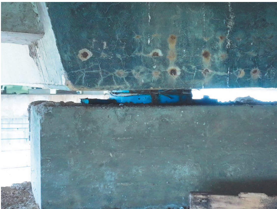
Particolare: apparecchio di appoggio a disco elastomerico confinato
