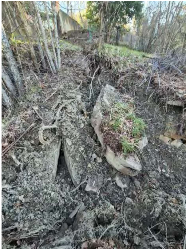
[Figura n. 4 – A sinistra: scivolamenti che dislocano il substrato roccioso; A destra: rottura di opere di contenimento terre in corrispondenza del piazzale antistante il fabbricato civile]
