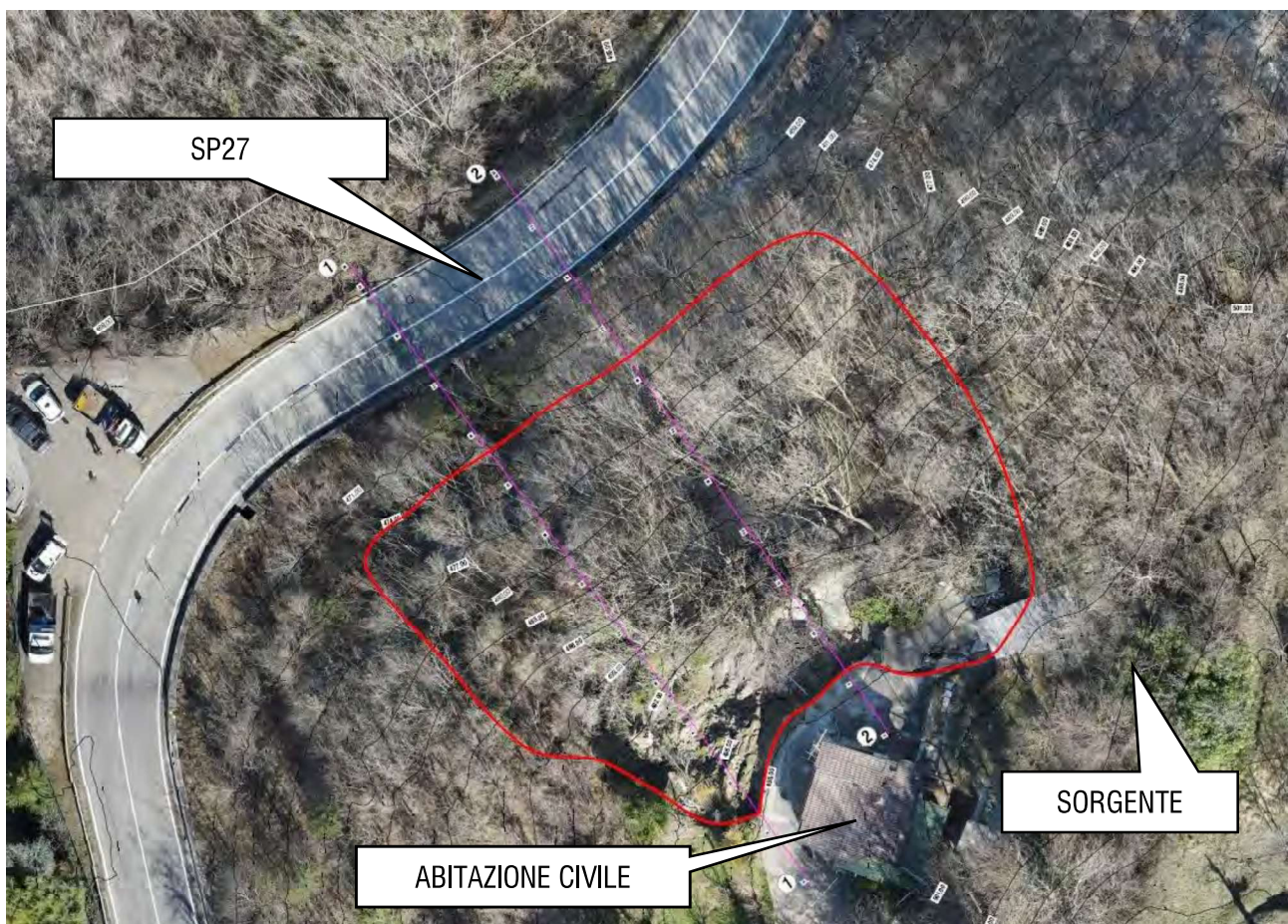
[Figura n. 2 – Indicazione estensione del dissesto su base ortofoto rilevata da UAV in data 19/03/2025]
