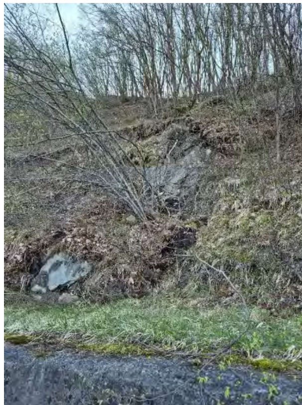
[Figura n. 6– A sinistra: emergenza idrica a monte del dissesto; A destra: fronti del dissesto più prossimi alla sede stradale]
